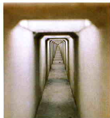
■ 側溝内部(流水面)の状況
