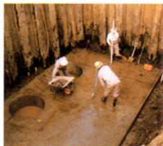
1 基礎ベースコンクリート状況
