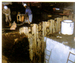
4 グラウト注入
