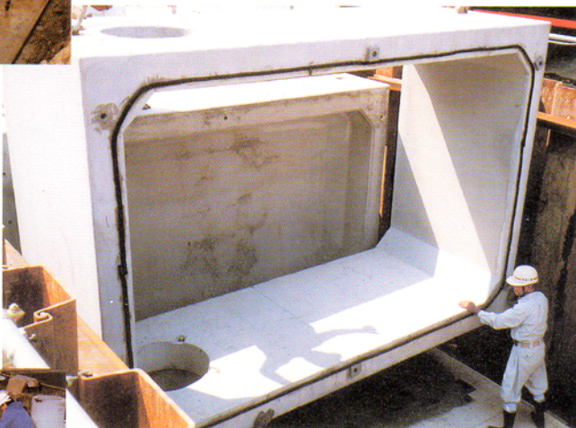
2 製品据付・組立
