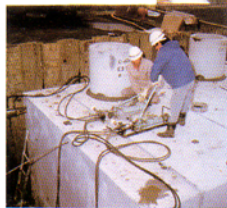
3 PC鋼より線の緊張
