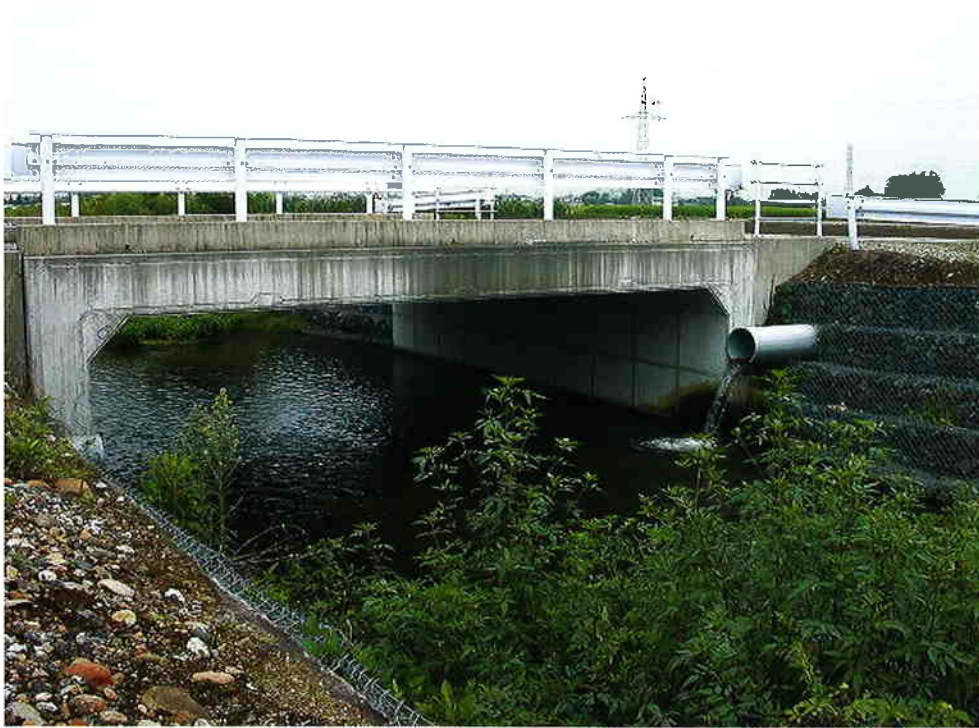
▲ カルバート橋 (河川)
