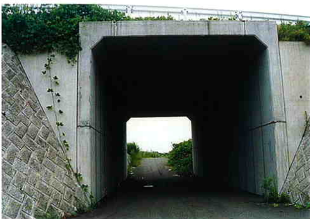
▲ カルバート橋 (道路)
