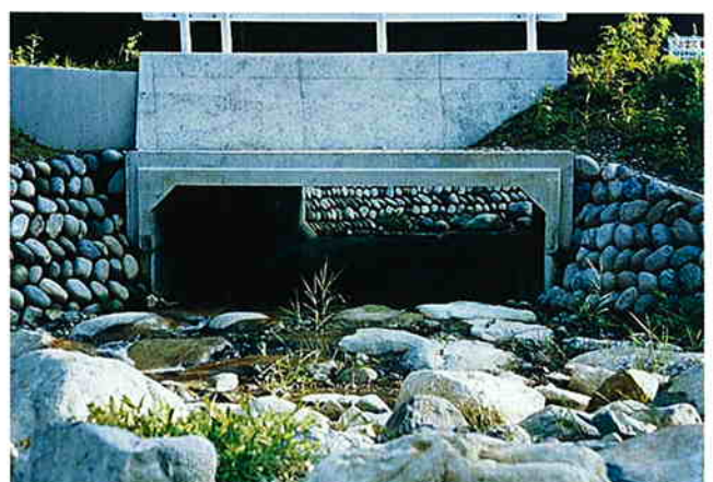
▲ カルバート橋 (河川)
