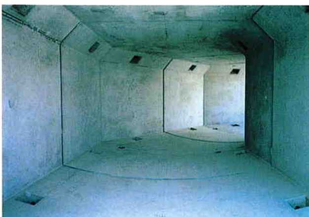
▲ カルバート内面状況 (インバート)
