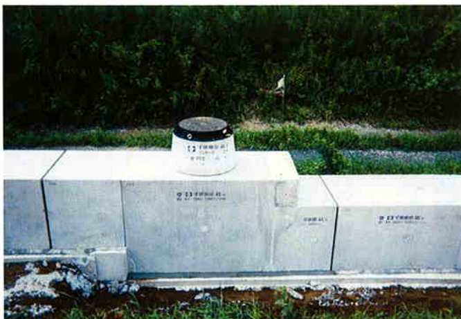
▲ 点検人孔取付
