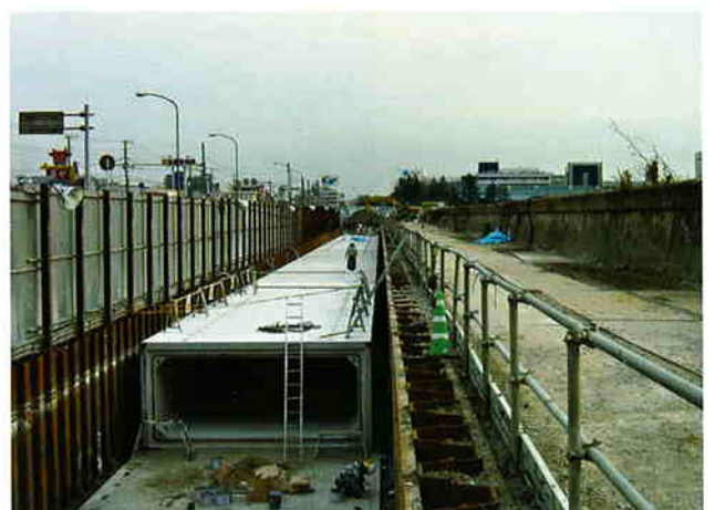
▲ 大型ボックスカルバート
