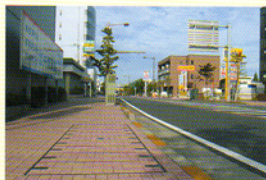
国道126号 千葉市都町 接続部
