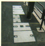
国道17号 群馬県前橋市上小出
