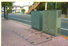
国道126号 同左 地上機器部(横置型)
