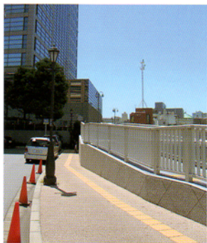
スロープ造成
