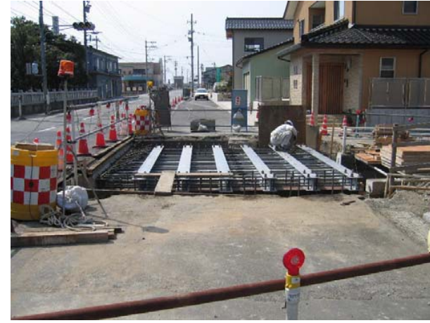
H鋼桁架設～桁下面型枠設置
