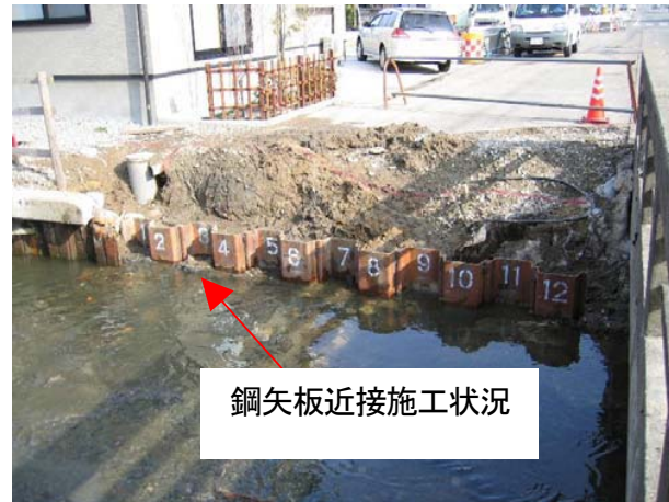
鋼矢板打設完了
