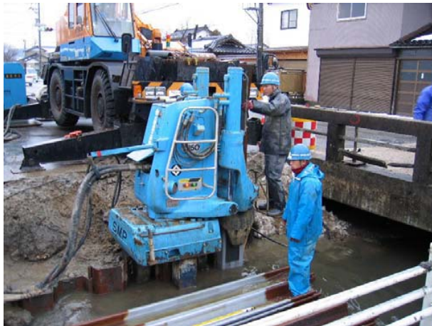
鋼矢板打設（圧入）状況
