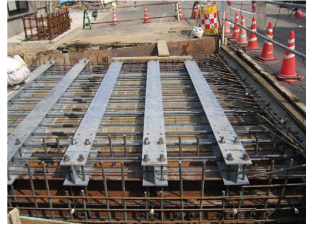
H鋼桁架設～桁下面型枠設置
