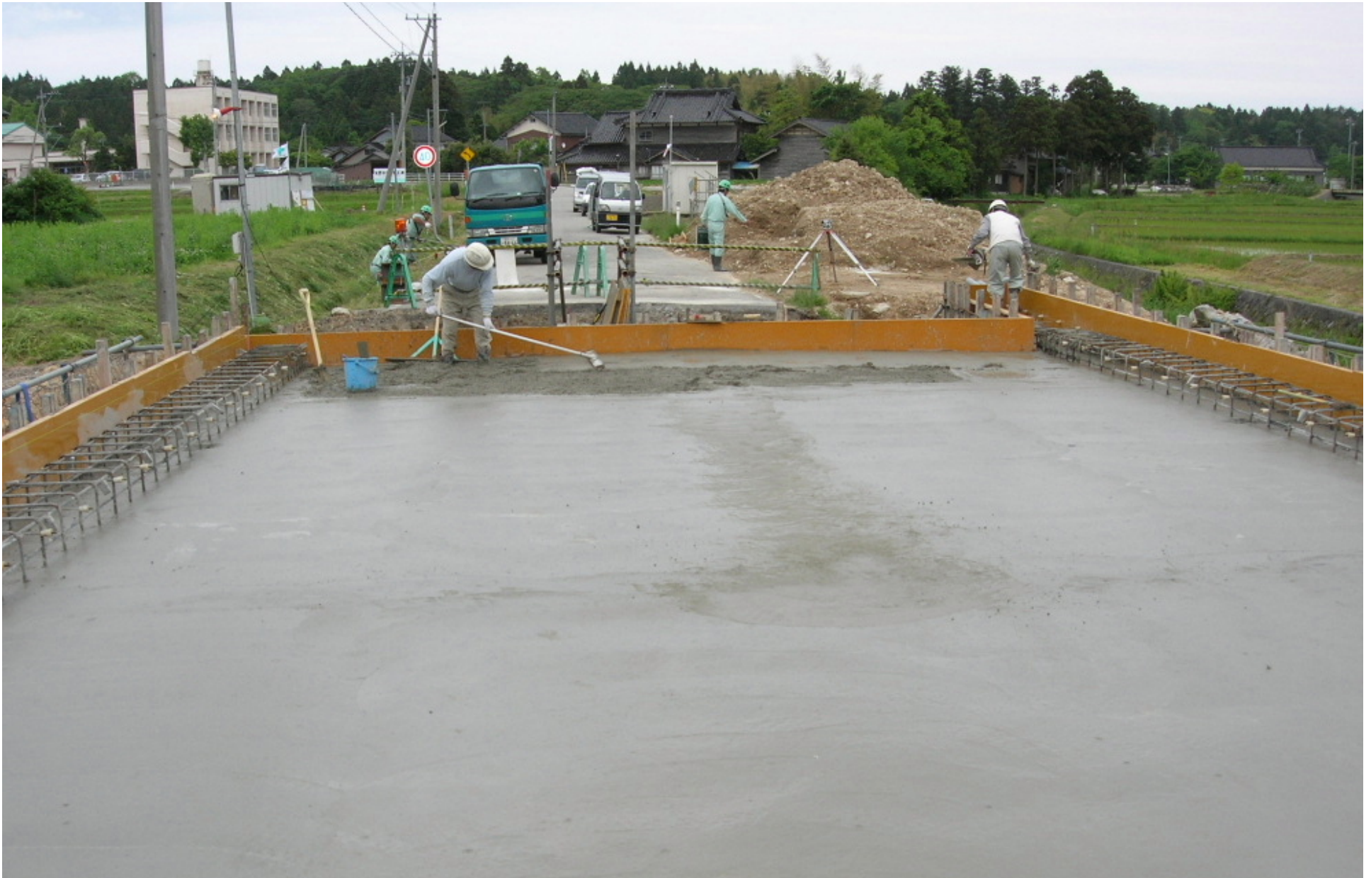
橋体コンクリート打設完了
