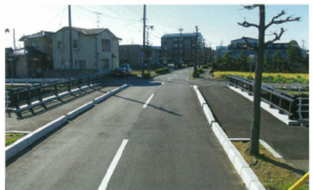
ジョイントレス構造施工例
