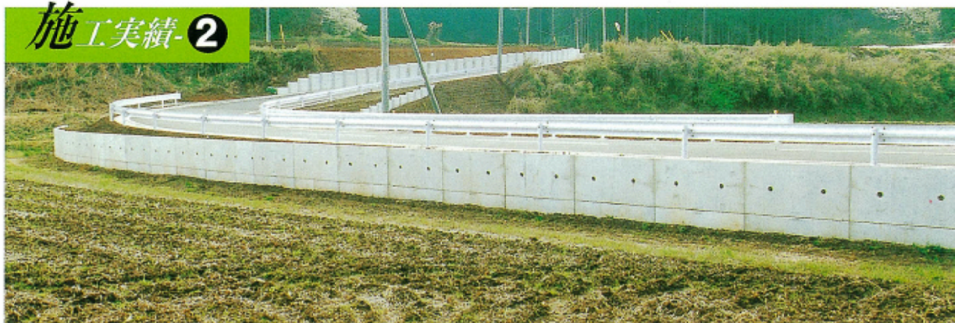
水田のような地盤が軟弱な現場にも対応し、しかも経済的な工事が可能（千葉県千葉市若葉区富田町）
