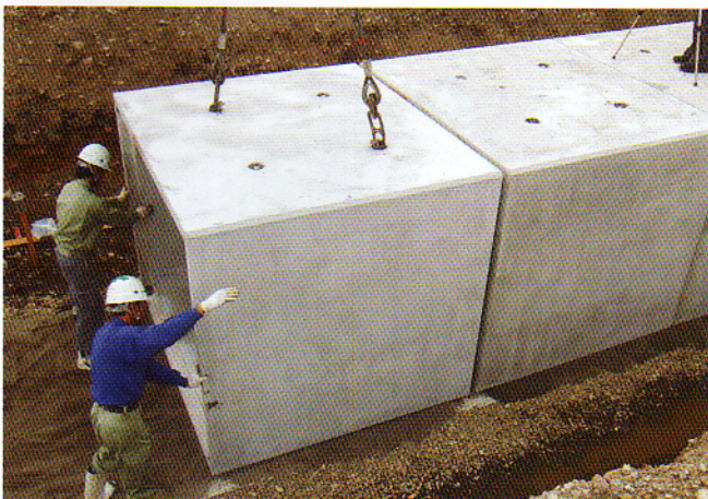
通常敷設状況
