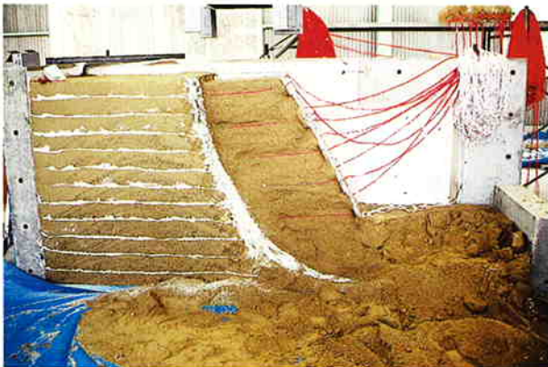
(補強材+表面保護パネル)の破壊後の様子
