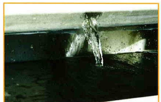
散水の排出状況
