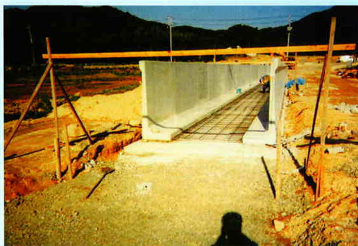
▲ 底板現場打ち部配筋状況
