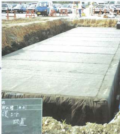
⑦ 遮水シート、保護シート敷設完了
