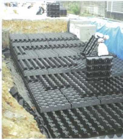
⑦ 遮水シート、保護シート敷設完了
