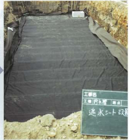
③ 遮水シート敷設
