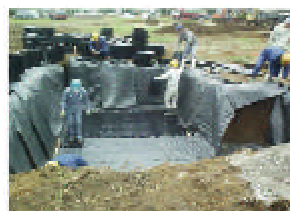
2 上下板の設置
