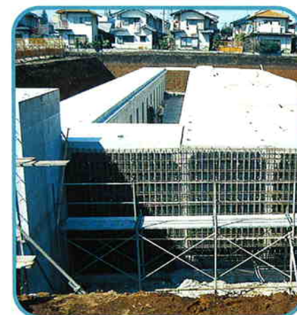
9 端壁（配筋状態）
