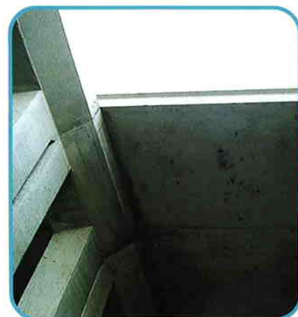
7 頂版部蓋掛状態
