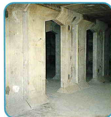
6 底版部打設完了
