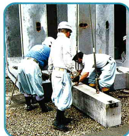
3 浸透貯留施設据付状態
