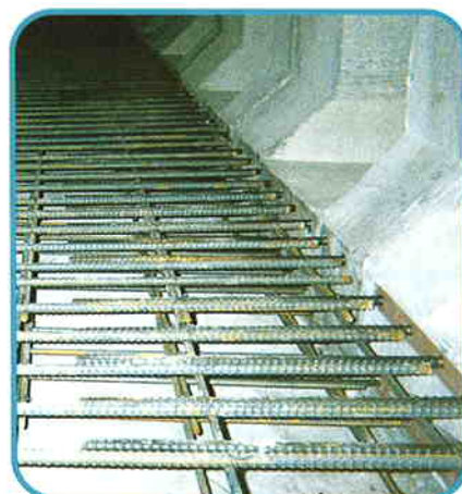
5 底版部配筋状態
