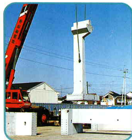
3 吊り上げ状態
