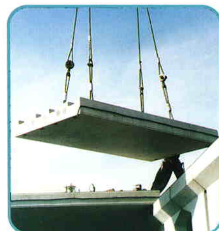
6 蓋吊り降ろし
