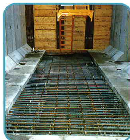
8 底版部配筋状態
