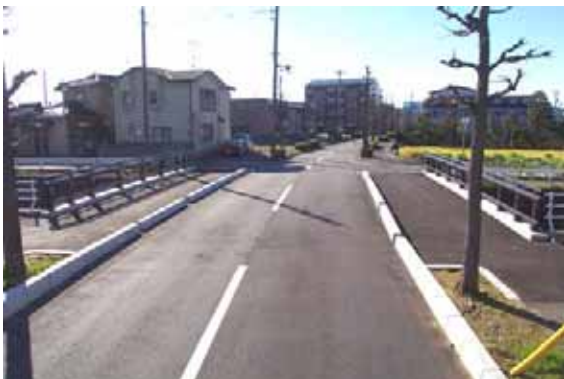
橋面状況 (架替後)
