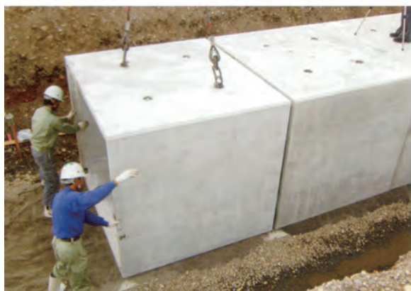
通常敷設状況
