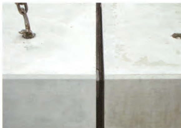
敷設後引き込み
