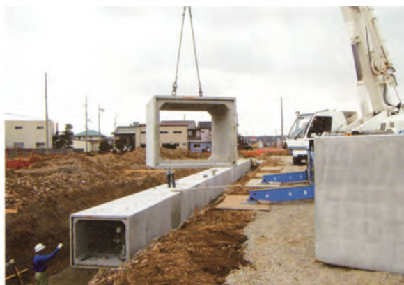
製品吊り込み
