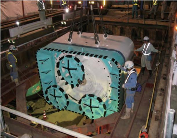
ボックス推進工法は、カッタ部を自転・公転方式とし、3軸の自転偏心ビットとそれらを受け持つ公転ギヤにより、公転1回転で矩形断面を一度に掘削する機構を可能としました。そのため、従来工法で課題であった、周辺環境への影響や施工費および施工工程などを解決することが可能となりました。
