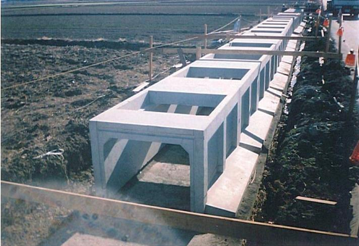
IS 側溝は、底部インバートコンクリートを打設した際、その断面が凸型形状となるため、水漏れなどの心配がない強固な底部の側溝に仕上がります。
