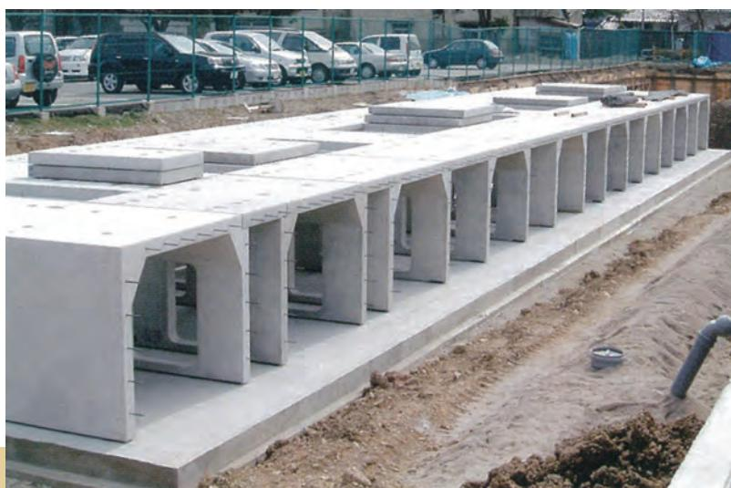
ミニゲートは自然流下式に有利な内高に規格化したことで経済的になった雨水貯留製品です。
